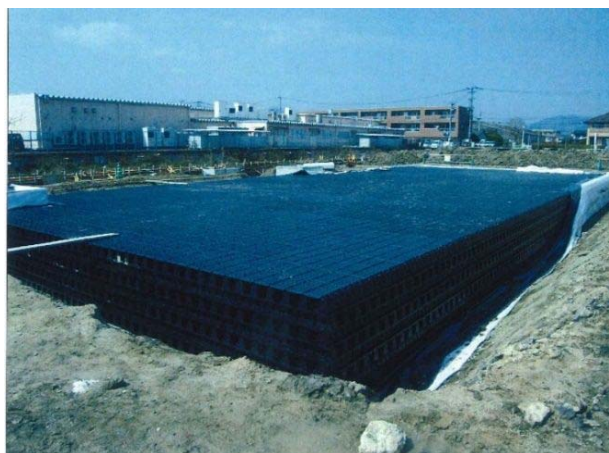
貯留施設設置状況
