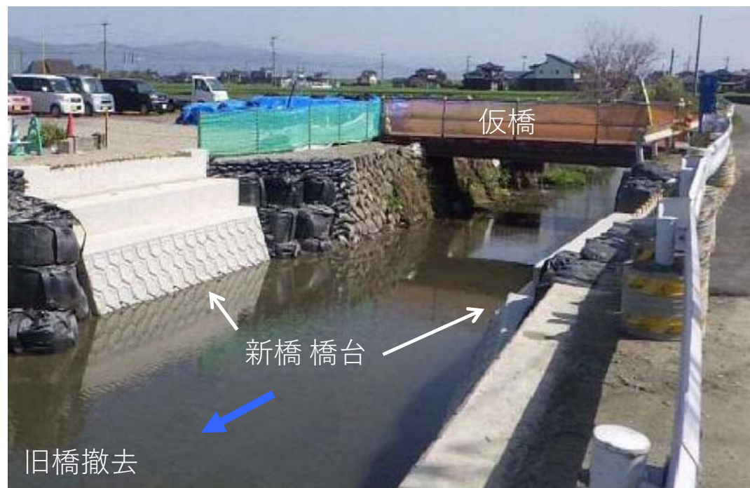
福所江（河道拡幅に伴う橋梁架け替え）
