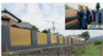
自主防災活動による量堤設置 (保保川水系、たつの市)
