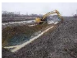
河道掘削 (石狩川水系、北海道開発局)
