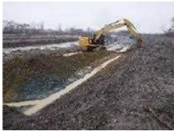
河道掘削 (石狩川水系、北海道開発局)
