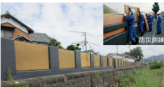
自主防災活動による畚堤設置 (揖保川水系、たつの市)
