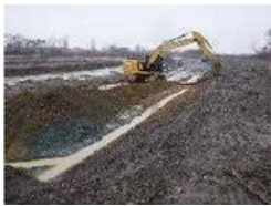
河道掘削 (石狩川水系、北海道開発局)
