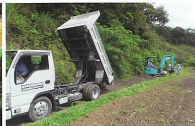
上ノトラックが入れなかった荒れ地に「道」をつくるプロジェクト。細かい部分は人の手で行う 右下ノ土や砂利をダンプで運び、バックホーで土を広げていく
