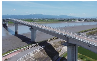
ろっかくがわおほし 六角川大橋
