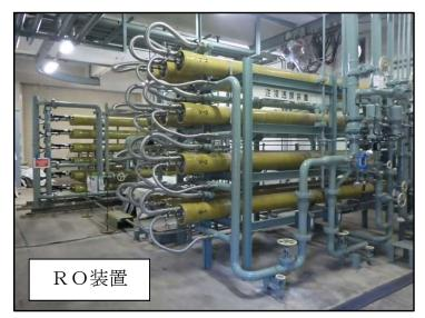
・RO装置(逆浸透膜装置)とは純水の純度向上を目的として設置したものです。
