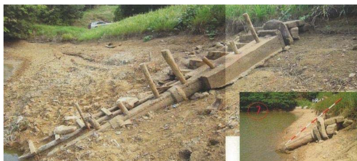
取水施設の老朽化状況
