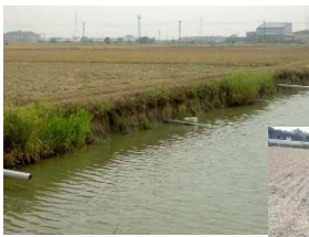
法面の浸食、崩落状況
