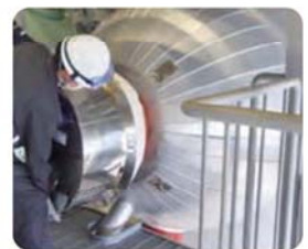
解体撤去の様子
