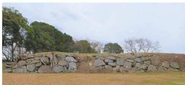
修理対象の石垣面(北東から撮影)
