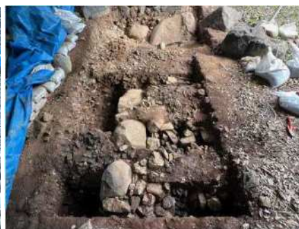
弾正丸下 第482調査区【①】 (南西から)
