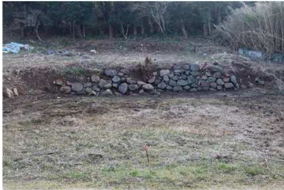
堀と枡形虎口の石垣部分(北東側より)
