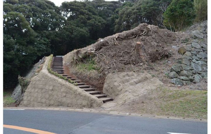
北側法面補強工事箇所(令和5年度施工)
