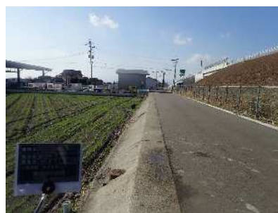
令和 8 年 1 月 13 日 (供用後)
