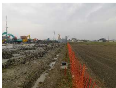
令和元年 12 月 16 日 (工事中)
