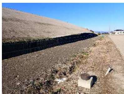
令和 3 年 2 月 8 日 (工事中)
