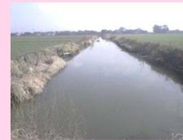
法面が崩落し洪水調整機能が低下
