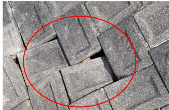
護岸背面の土砂吸出し状況
