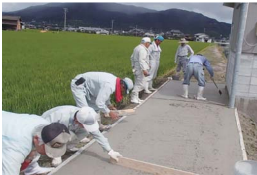
地域ぐるみの取組による農道舗装
