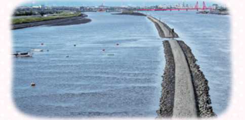
筑後川河口から若津港(大川市)まで続く デ・レイケ導流堤 (新田大橋から撮影)
