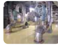
解体撤去中の第3低圧給水加熱器(これから蒸気発生器に入る水を加熱する装置)
