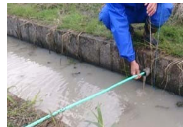
写真6 逆噴射ノズルによる排水管の清掃（佐賀農技防）
