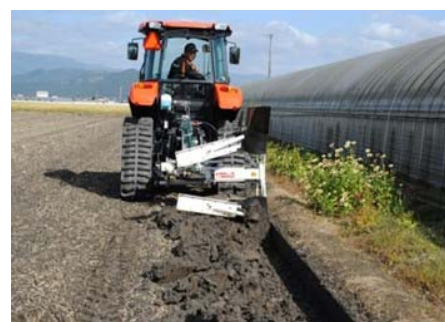
写真7 額縁排水の施工（佐賀農技防）
