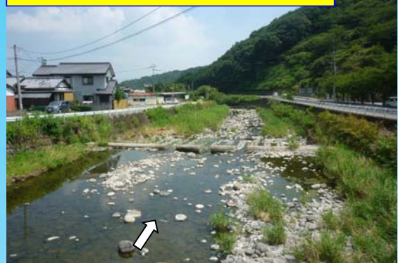
祐徳橋（市道）より下流を望む
