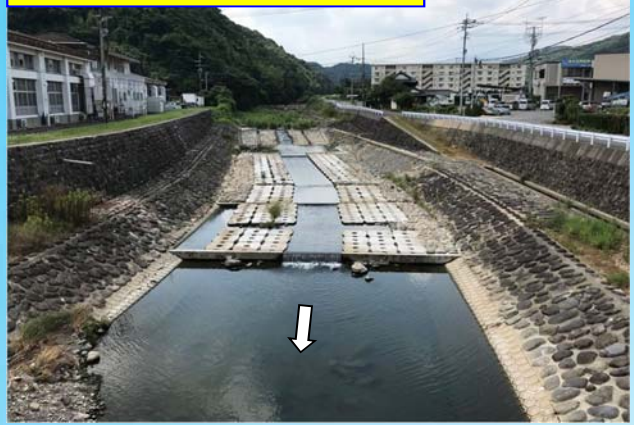
古場切橋より上流を望む
