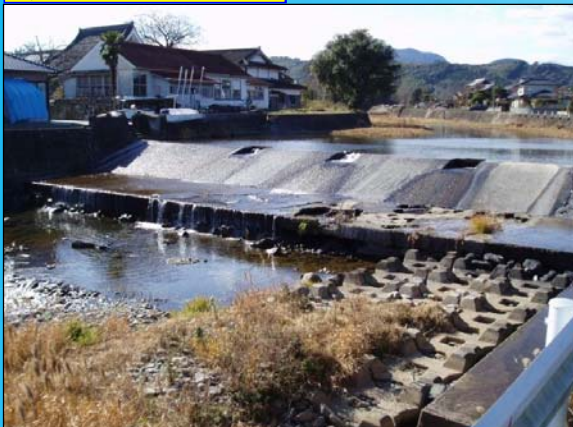
改修前(固定堰)
