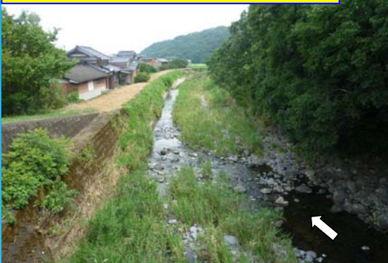
祐徳橋（県道）より下流を望む
