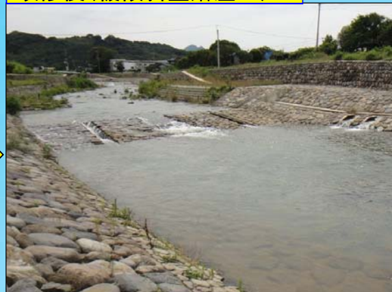
改修後(緩傾斜型落差工)
