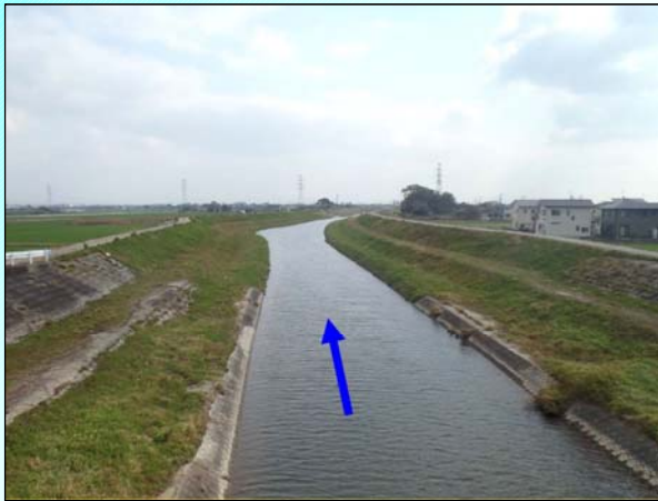
<1号橋下流区間> 護岸に覆土し、植生の 拡大を図った。
