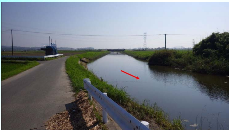
町道橋から上流を望む (河床掘削が残っている)
