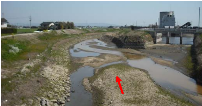
改修後の河川
