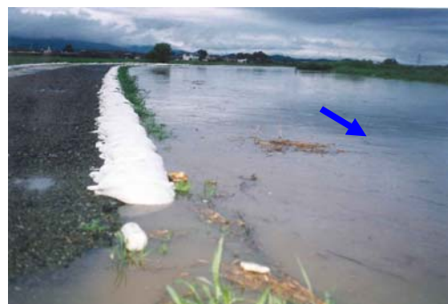
(国道264号より上流)
