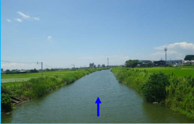
本川 新橋(5k390)より下流を望む
