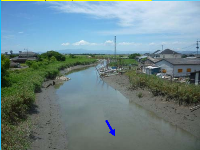
本庄江橋(0k900)より上流を望む
