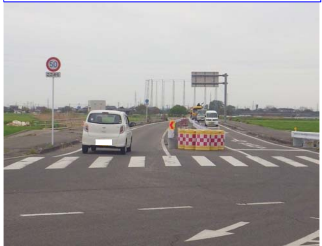
整備済区間 終点側より（神崎市脊振側から佐賀市街側を望む）
