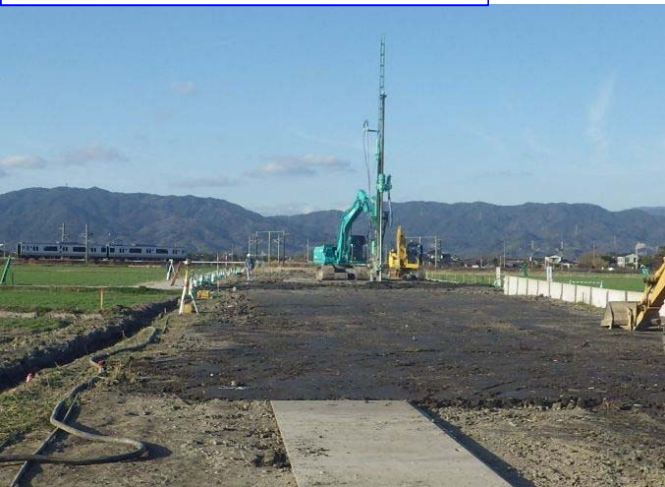
起点側より（佐賀市街側から神崎市脊振側を望む）
