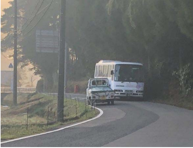
起点側より（伊万里市側から唐津市側を望む）
