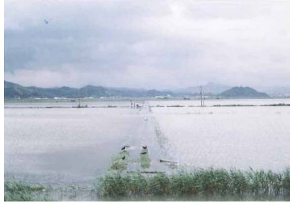
▲ 越波や降雨により冠水した背後地
