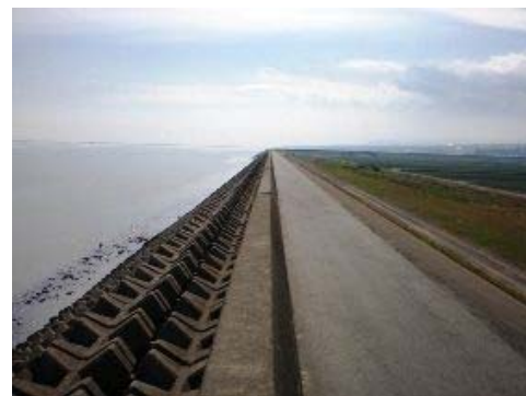
▲ 堤防の整備状況
