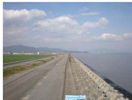
▲堤防の整備状況
