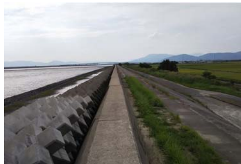
▲堤防の整備状況
