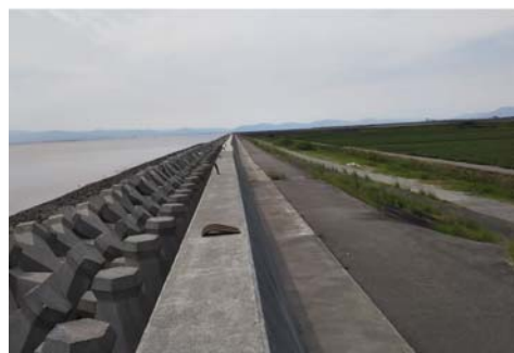
▲ 堤防の整備状況
