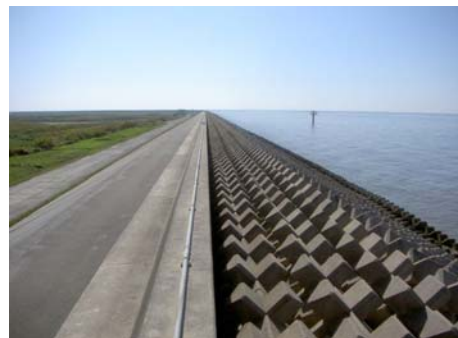
▲堤防の整備状況
