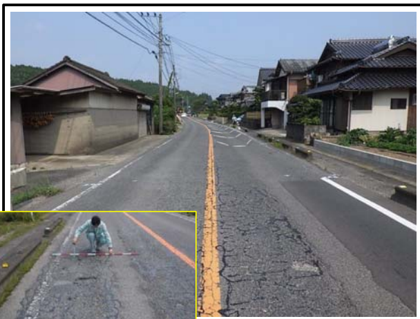
わだち掘れ、ひび割れ状況
