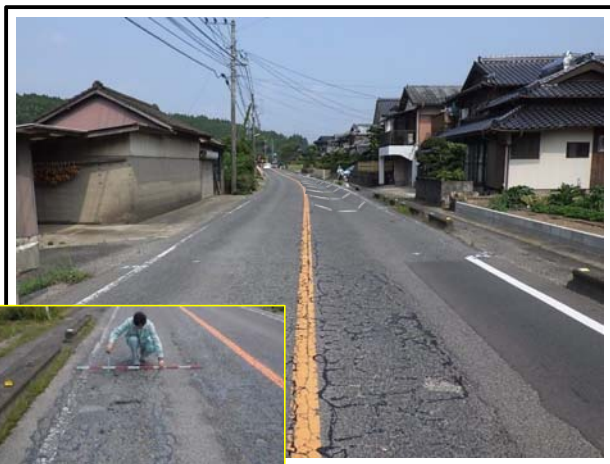
わだち掘れ、ひび割れ状況
