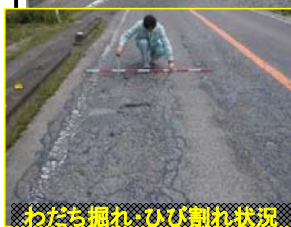
わだち掘れ、ひび割れ状況
