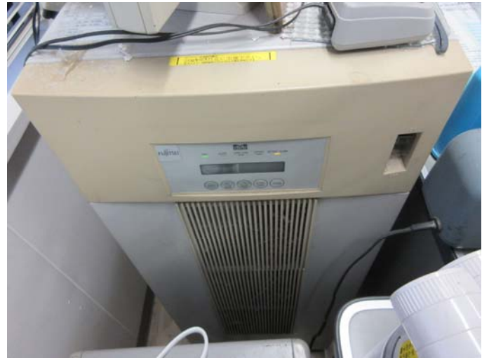
電源施設の更新
