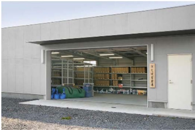
(他県事例) 備蓄倉庫
