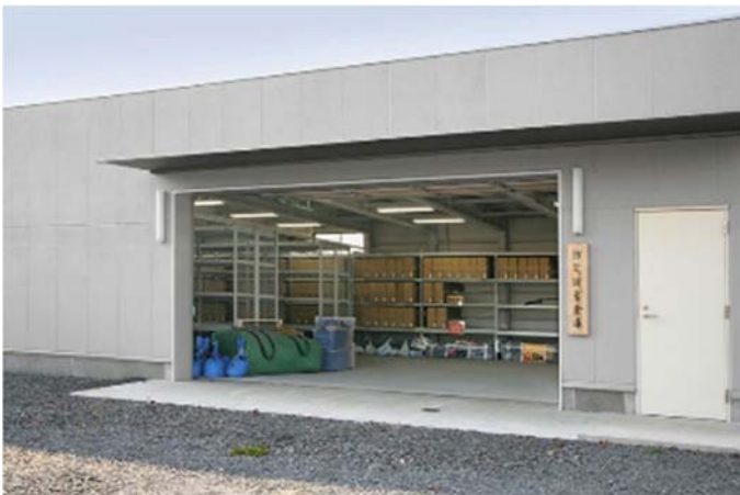
（他県事例）備蓄倉庫
