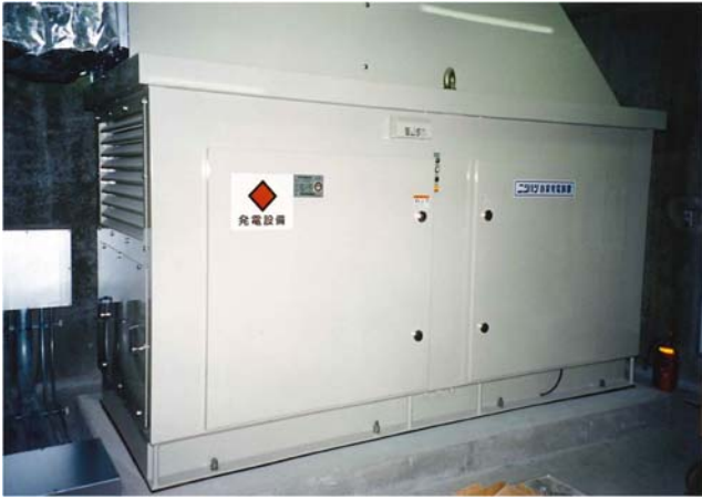
自家発電設備更新、浸水対策
