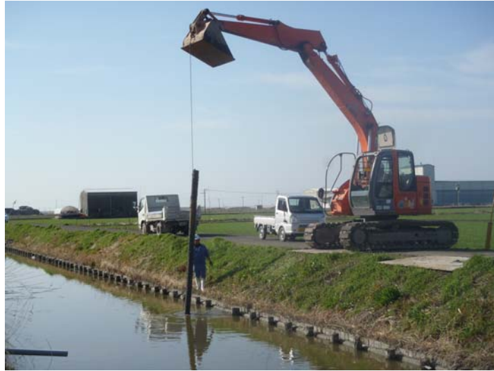
写真-2 クリーク防災杭の採取状況(大詫間地区水路)
