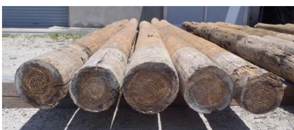
写真 - 4 杭頭状況
