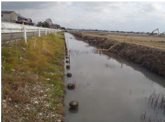
写真 - 9 現地施工状況
