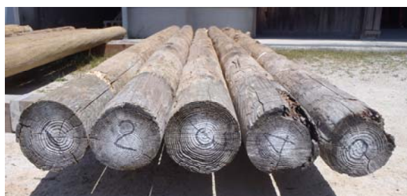
写真 - 7 杭頭状況
