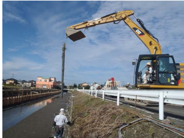
写真-2 クリーク防災杭の採取状況(川副町西古賀)
