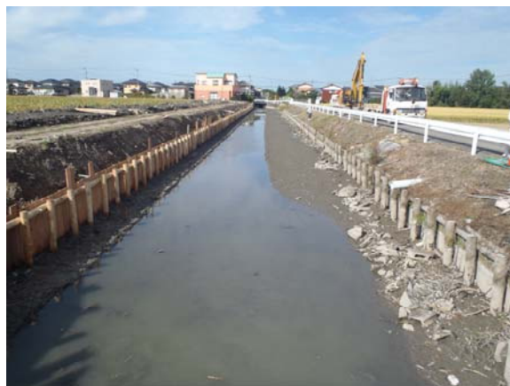
写真 - 6 現地施工状況
