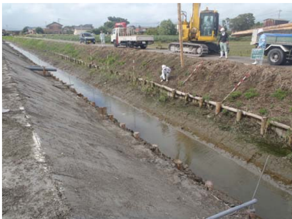
写真 - 3 現地施工状況
