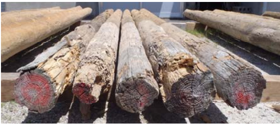
写真 - 16 杭頭状況
