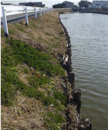
写真 - 15 杭引抜現地状況
