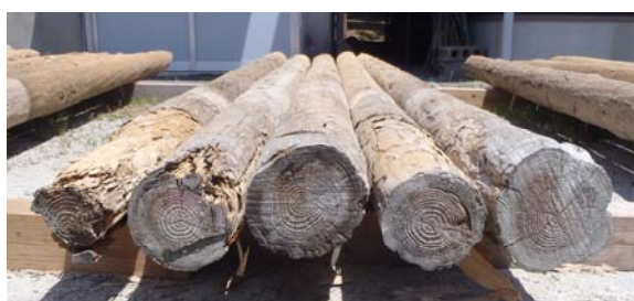
写真 - 13 杭頭状況
