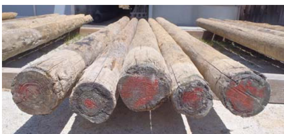
写真 - 10 杭頭状況
