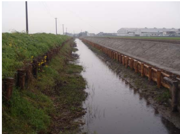
写真 - 12 杭引抜現地状況
