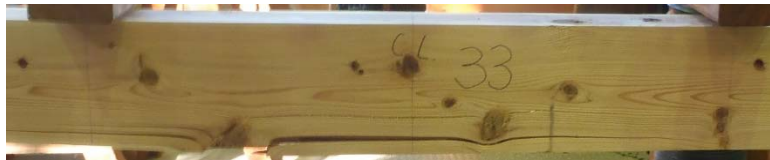
目視等級 1 級の試験体 (破壊試験後)
