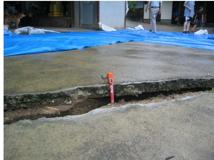
宅地土間コンクリートの亀裂
