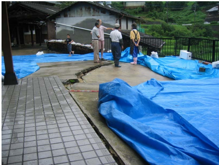
宅地土間コンクリートの亀裂
