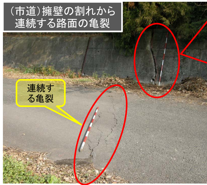
(市道)ブロック積み擁壁の割れ
