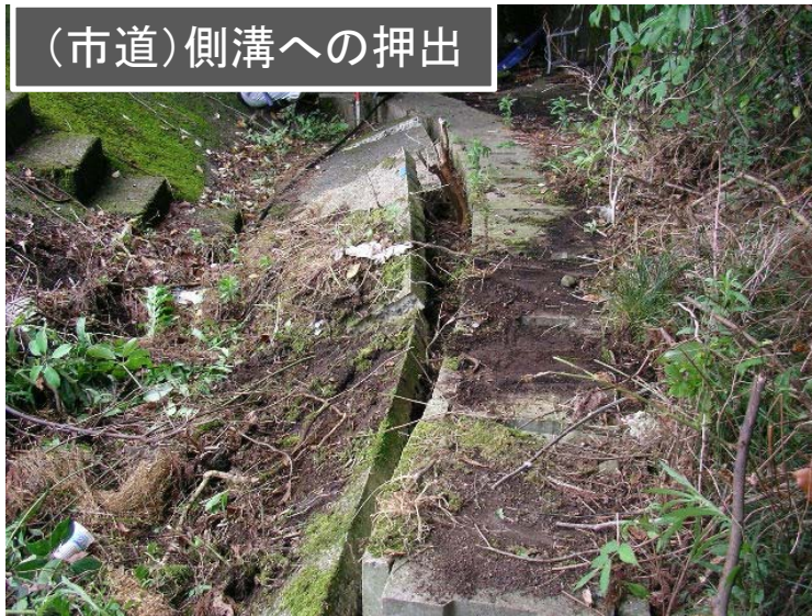
(市道)ブロック積み擁壁の割れ
