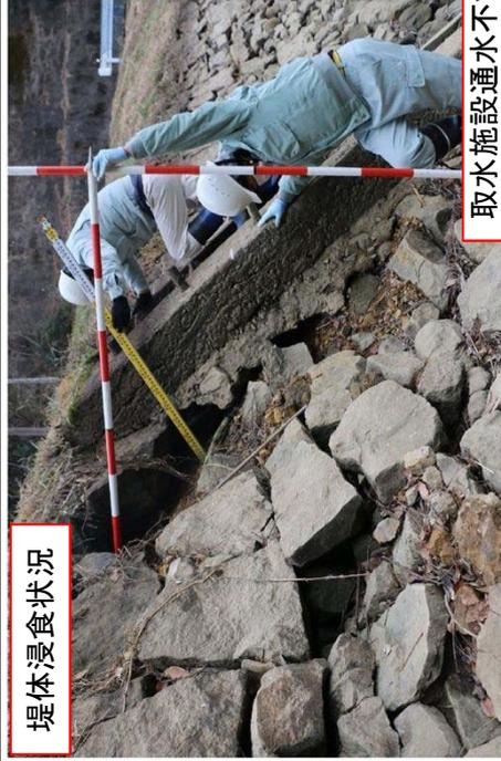
堤体下流法尻からの漏水状況
