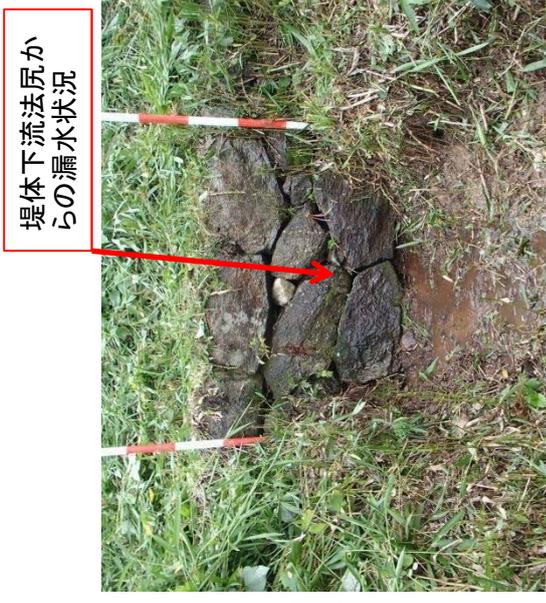
堤体下流法尻からの漏水状況
