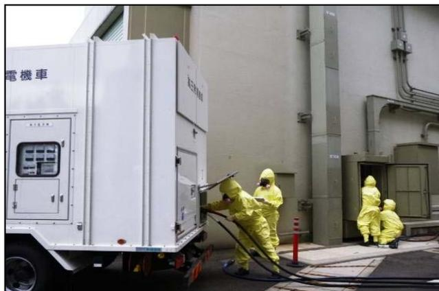
◇高圧発電機車の電源ケーブル接続
