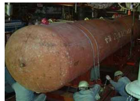
2次系設備の解体撤去 写真は過去の熱交換器取替工事
