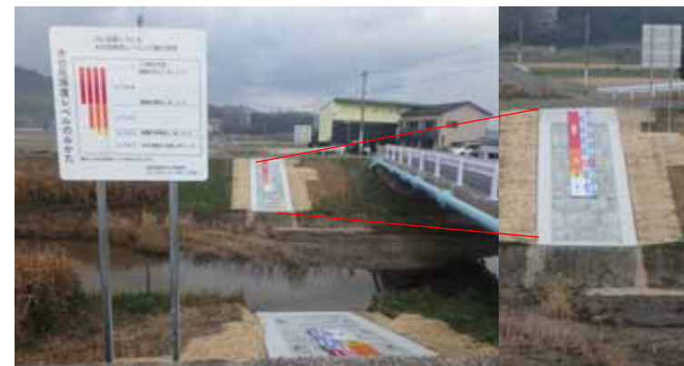
水位レベル表示(量水標)の設置 (宇木川 久里崎橋)
