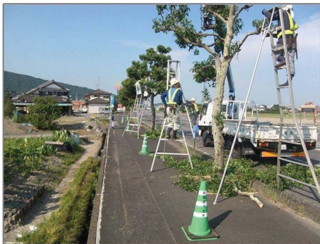
剪定状況（国道207号：鹿島市）
