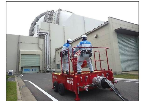
◇放水砲の設置
