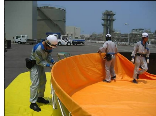
◇中間受槽(水槽)の設置
