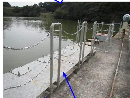
足場常設設置
