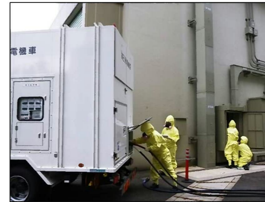
◇高圧発電機車の電源ケーブル接続 (汚染防護具着用)
