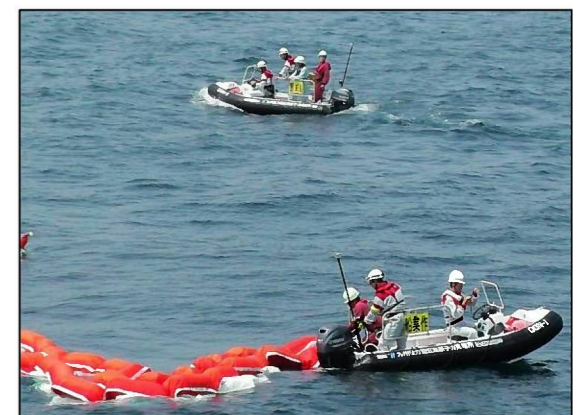
◇シルトフェンス(海中カーテン)の設置
