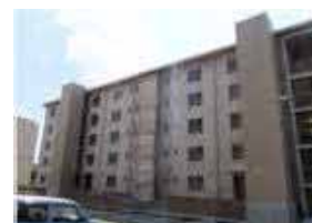
↑ エレベーター設置による共用部分のバリアフリー化
