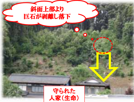
対策工実施箇所（全景）
