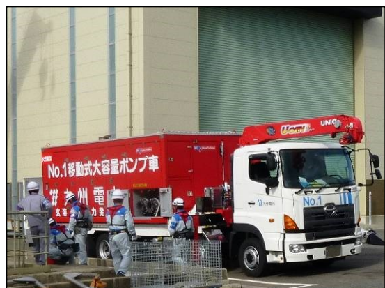
◇移動式大容量ポンプ車の設置
