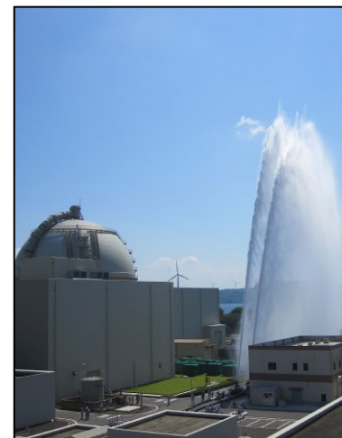
◇放水砲による放水
