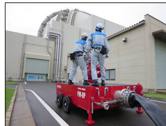
◇放水砲の設置
