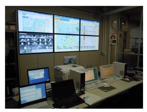
佐賀県環境放射線モニタリングシステム中央監視局【環境センター】 ▶ モニタリングポストからの測定データを収集・処理し、常時監視
