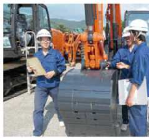
〈現場研修〉 現場のリアルを体感しながら学びます。
